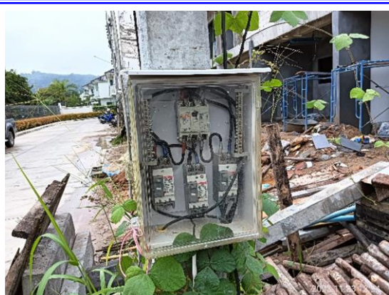
รูปที่ 3-33 อุปกรณ์ตัดไฟอัตโนมัติเมื่อเกิดเหตุฉุกเฉิน
