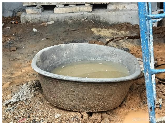
รูปที่ 3-23 กระบะสำหรับไว้ล้างอุปกรณ์ก่อสร้าง
